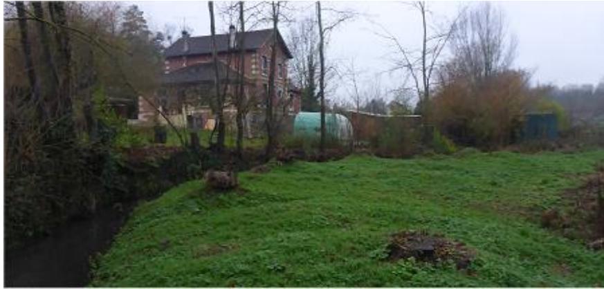
Photo 1 : Vue générale de la station du ru de la Garde
