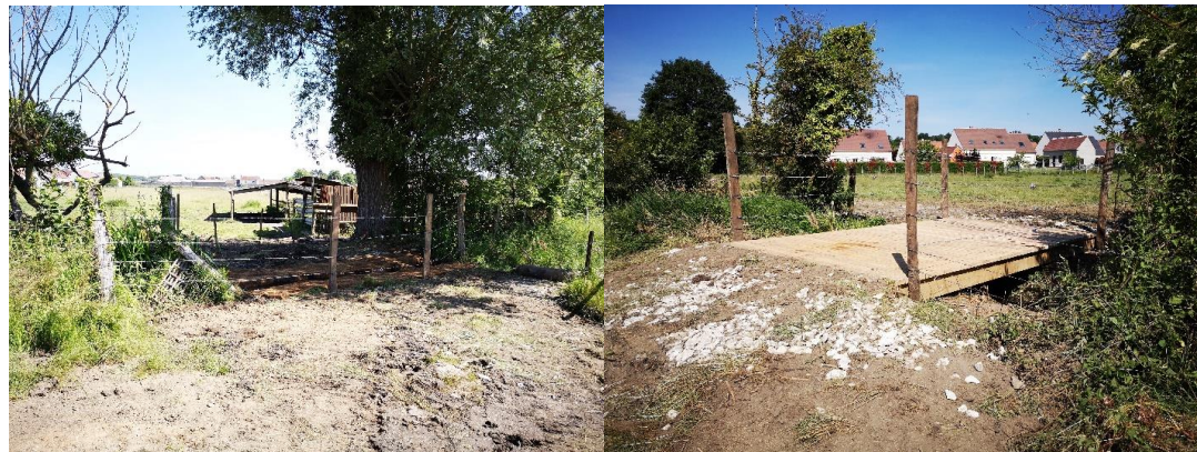
Figure 4 : Mise en défens des berges du Ru de la Garde, création d'une passerelle pour le passage des bovins (SMBVB, 2020)
