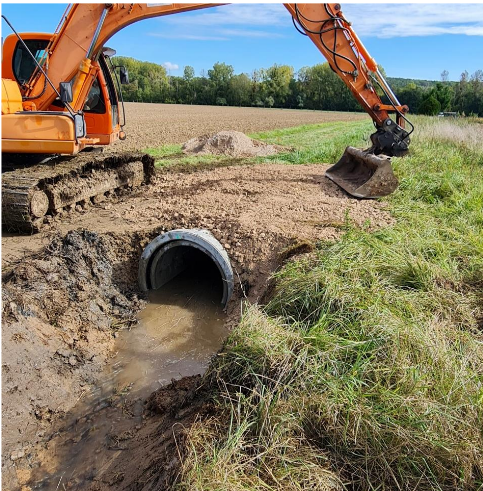
Figure 13 : Remplacement d'un ouvrage sur le Ru du Rotbelex (SMBVB, 2021)
