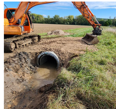
Figure 5 : Remplacement de buse Ru de Rotheloux (2021, SMBVB)
