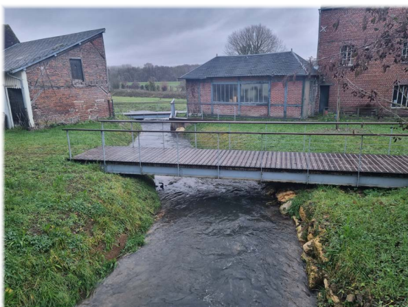
Vue du site depuis l'amont, après suppression
