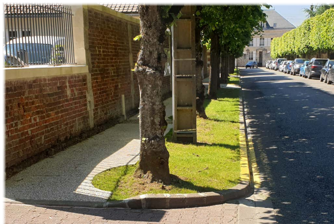
Exemple d'action de désimperméabilisation de l'espace public et de gestion du pluvial à la source
