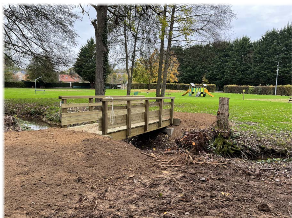
Passerelle installée au-dessus de la Brèche
