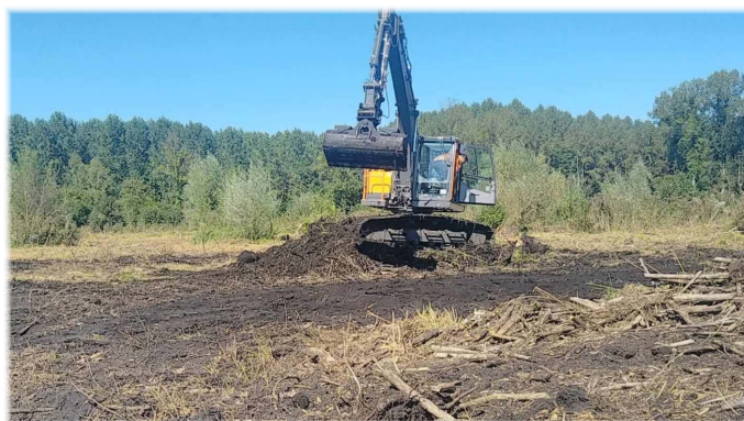
Travaux en cours sur Rantigny
