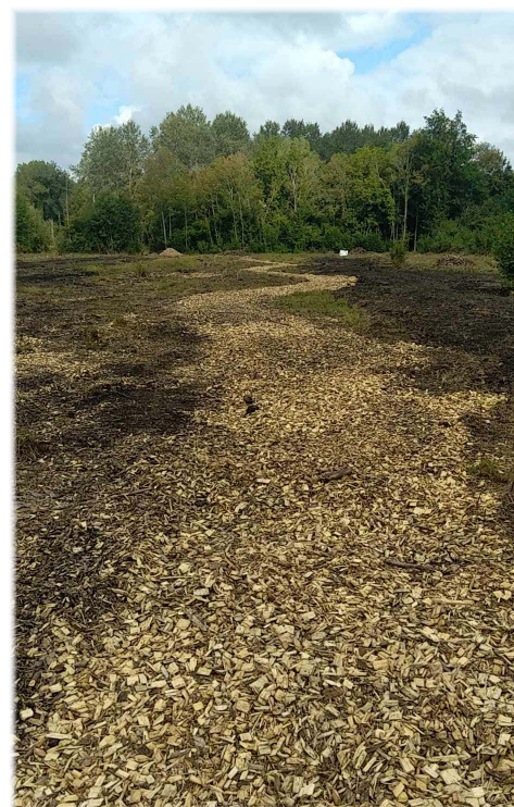
Mise en place d'un sentier à Rantigny
