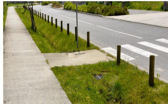
Figure 21 : Coupe type d'une noue trapézoïdale Source : INFRA Services
