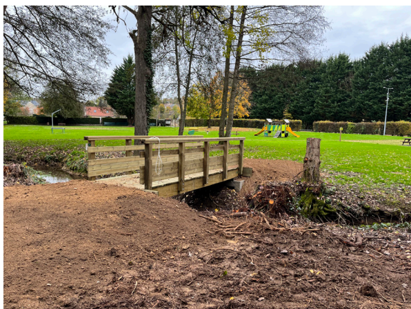
Passerelle installée au-dessus de la Brèche
