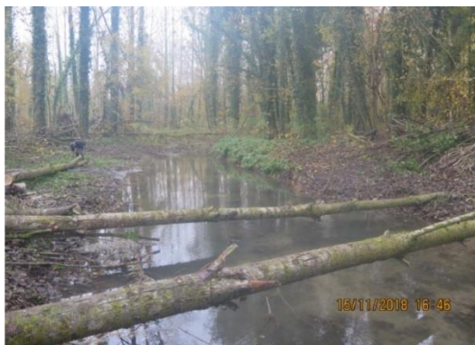
Figure 18 : Avant/après retrait d'embâcles empêchant le bon écoulement
