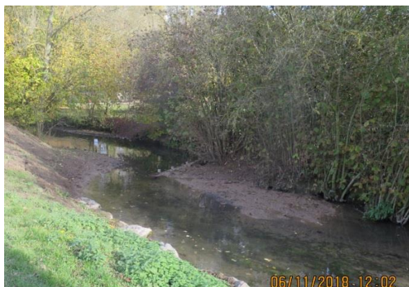
Figure 14 : Mise en place de déflecteurs et apport de terre
