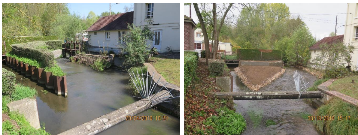
Figure 21 : Moulin du Pont de Pierre avant et après travaux
