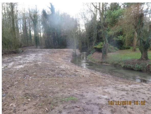
Figure 13 : Avant/après suppression des merlons de curage et restauration d'une berge en pente douce
