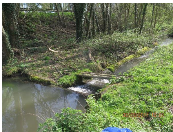
Figure 23 : Déversoir de la RN31
