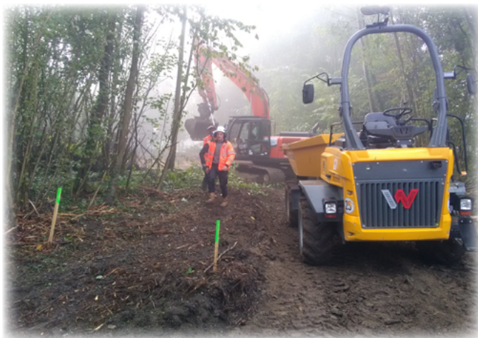
Terrassement du nouveau lit
