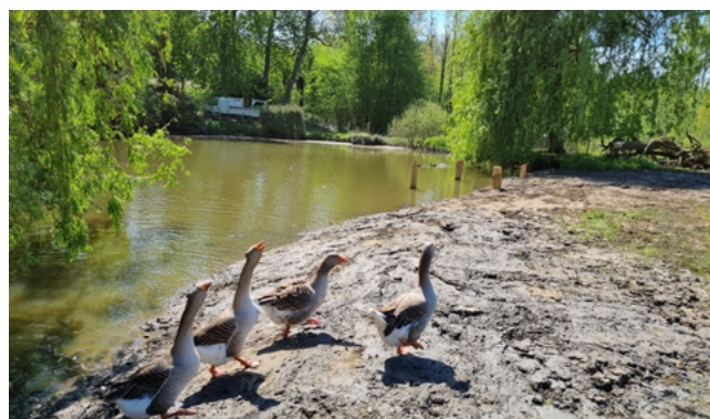
Reprise des berges de l'étang à la suite de la tranche 1
