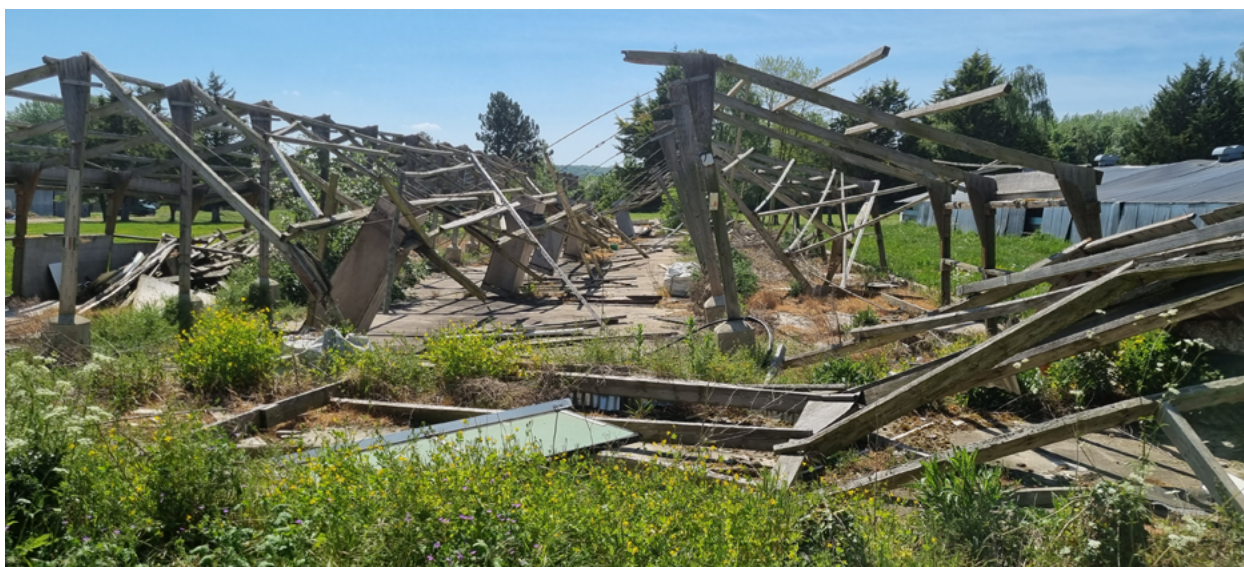
Poulaillers à démonter avant la réalisation des travaux
