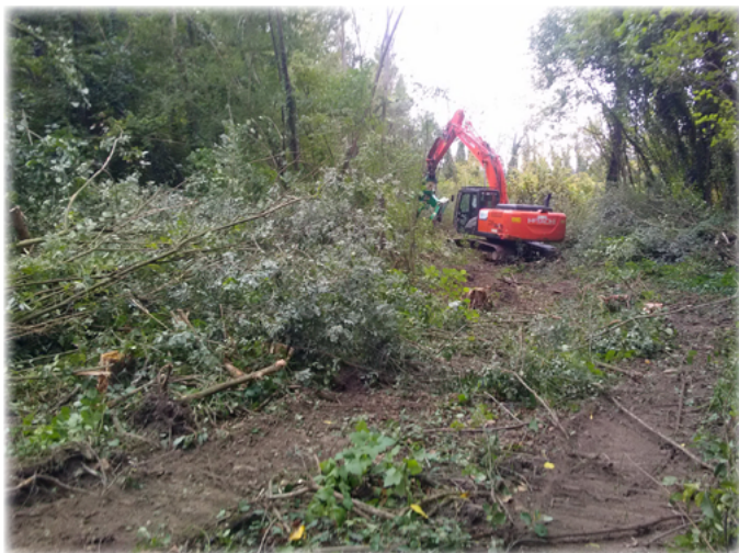
Abattage préalable aux travaux
