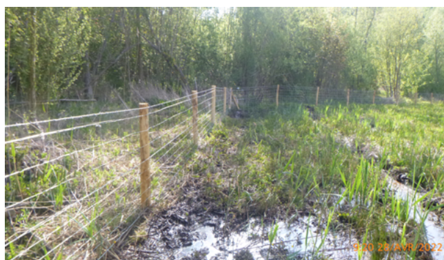
Pose de clôture
