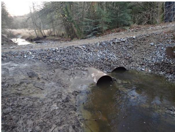
Figure 29 : Exemple de buses et passage d'engin
