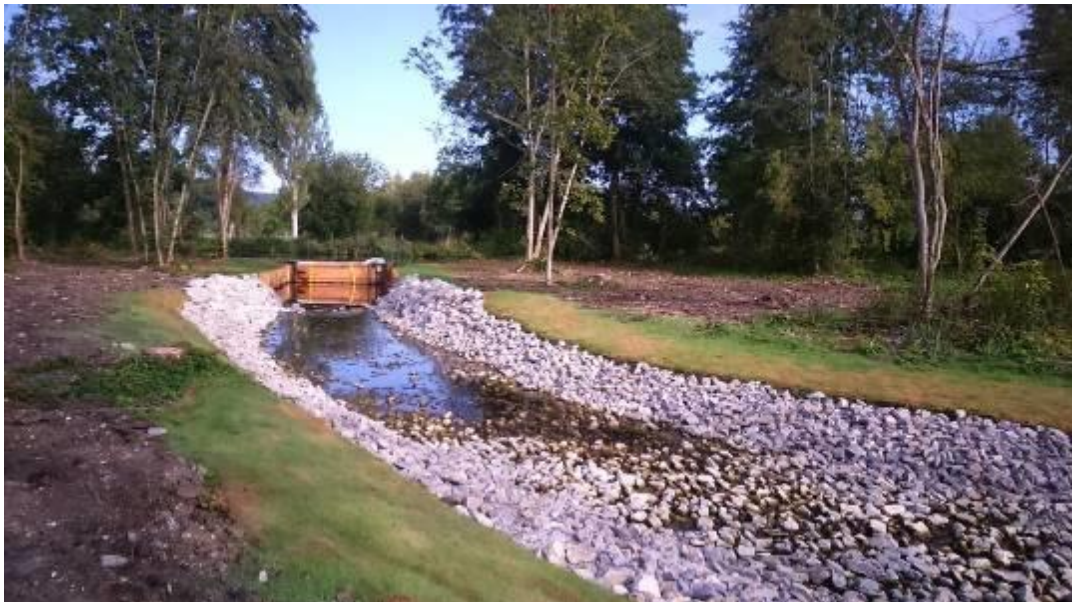
Figure 12 : Photographie de fond aménagé d'enrochements– Le Vaudreuil (27) (SOGETI 2015)
