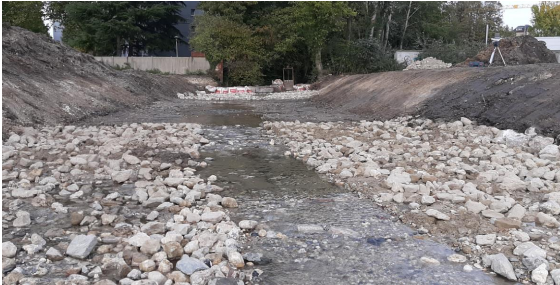
Exemple de radier – RCE du moulin Tiffine sur le Cailly à maromme (76) – MOE SOGETI 2020
