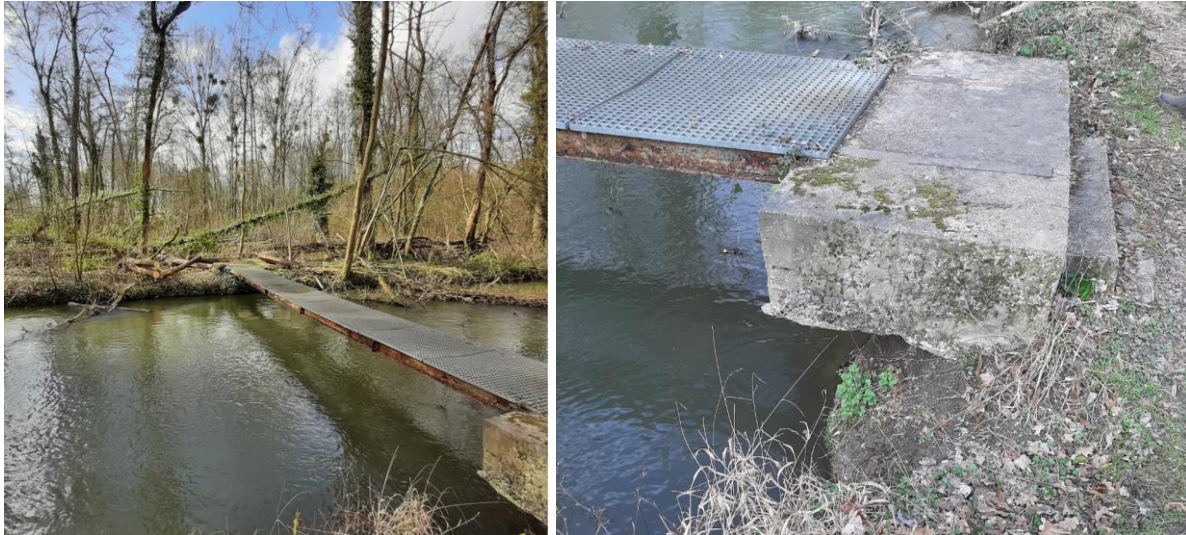
Vues de la passerelle amont
