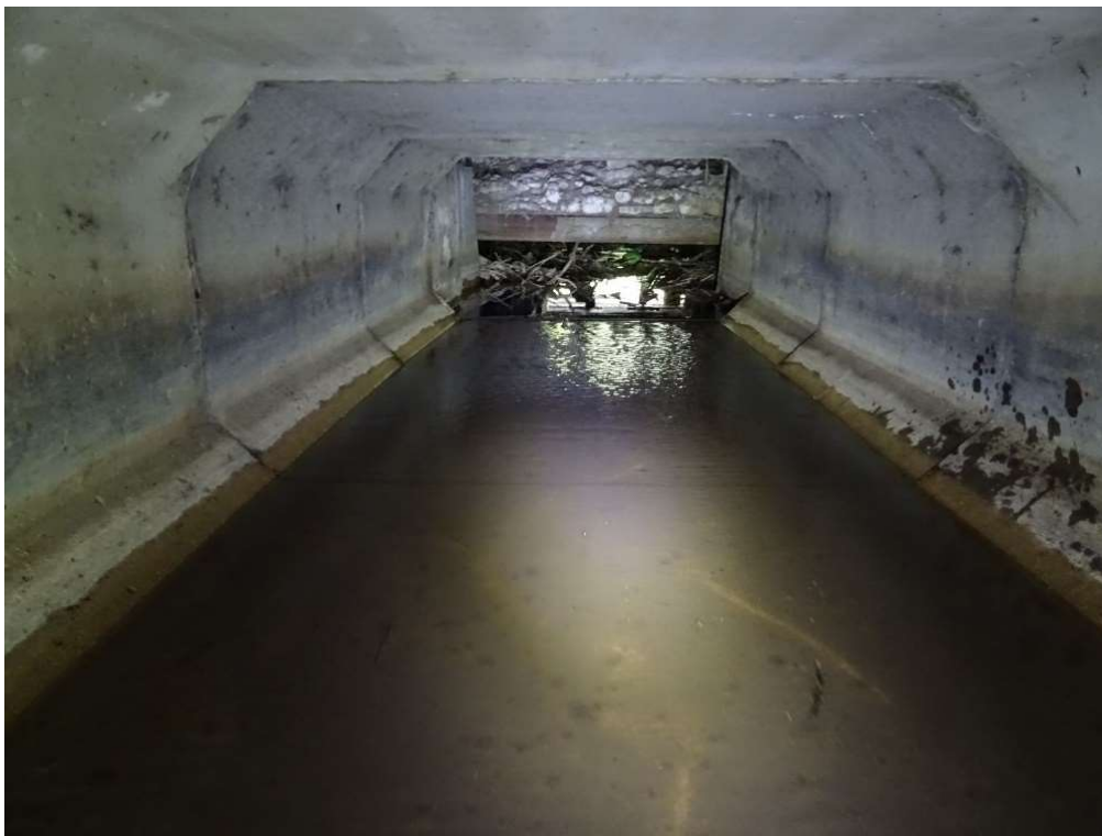
Ph.6 Vue de la structure N°4
