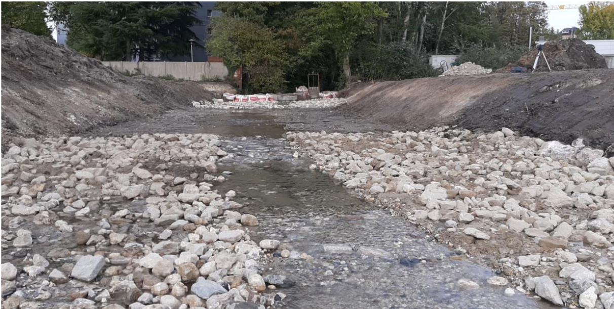
Figure 7 : Exemple de radier – RCE du moulin Tiffine sur le Cailly à Maromme (76) – MOE SOGETI 2020
