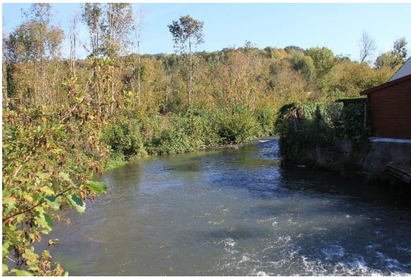
Bras de décharge - aval de l'ouvrage
