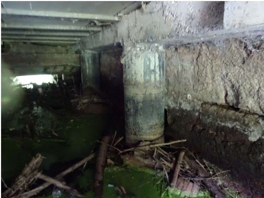
Ph.4 Vue de la structure n°1
