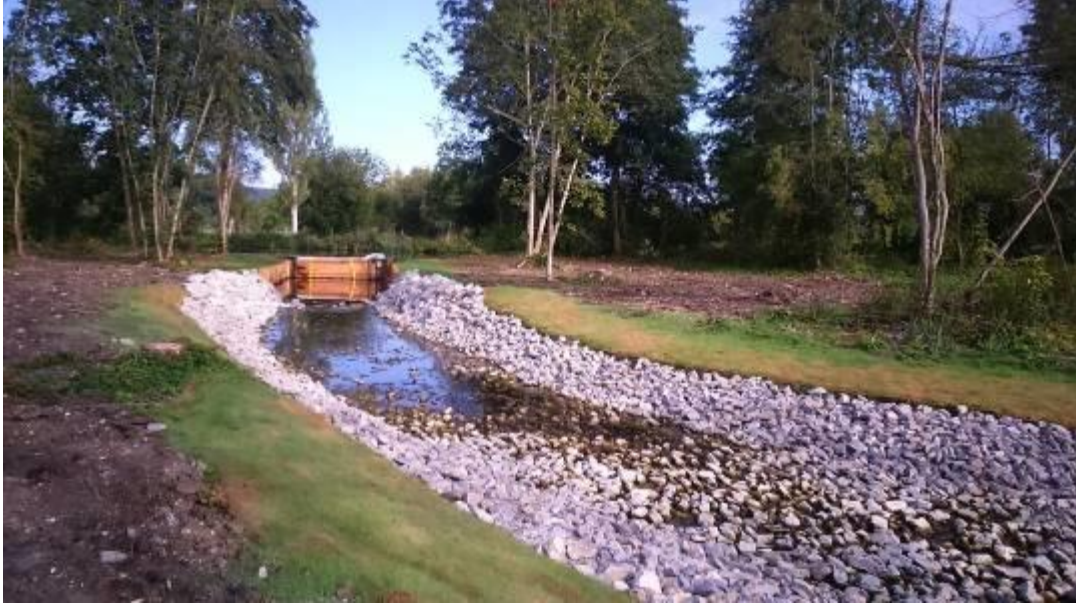
Photographie de fond aménagé d'enrochements- Le Vaudreuil (27) (SOGETI 2015)
