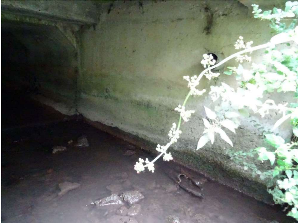
Ph.7 Vue de la structure n°5
