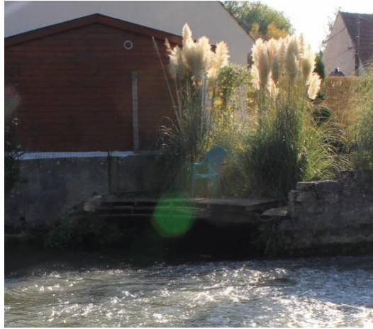
Ponton en bois en rive gauche, en aval de l'ancien ouvrage de dérivation
