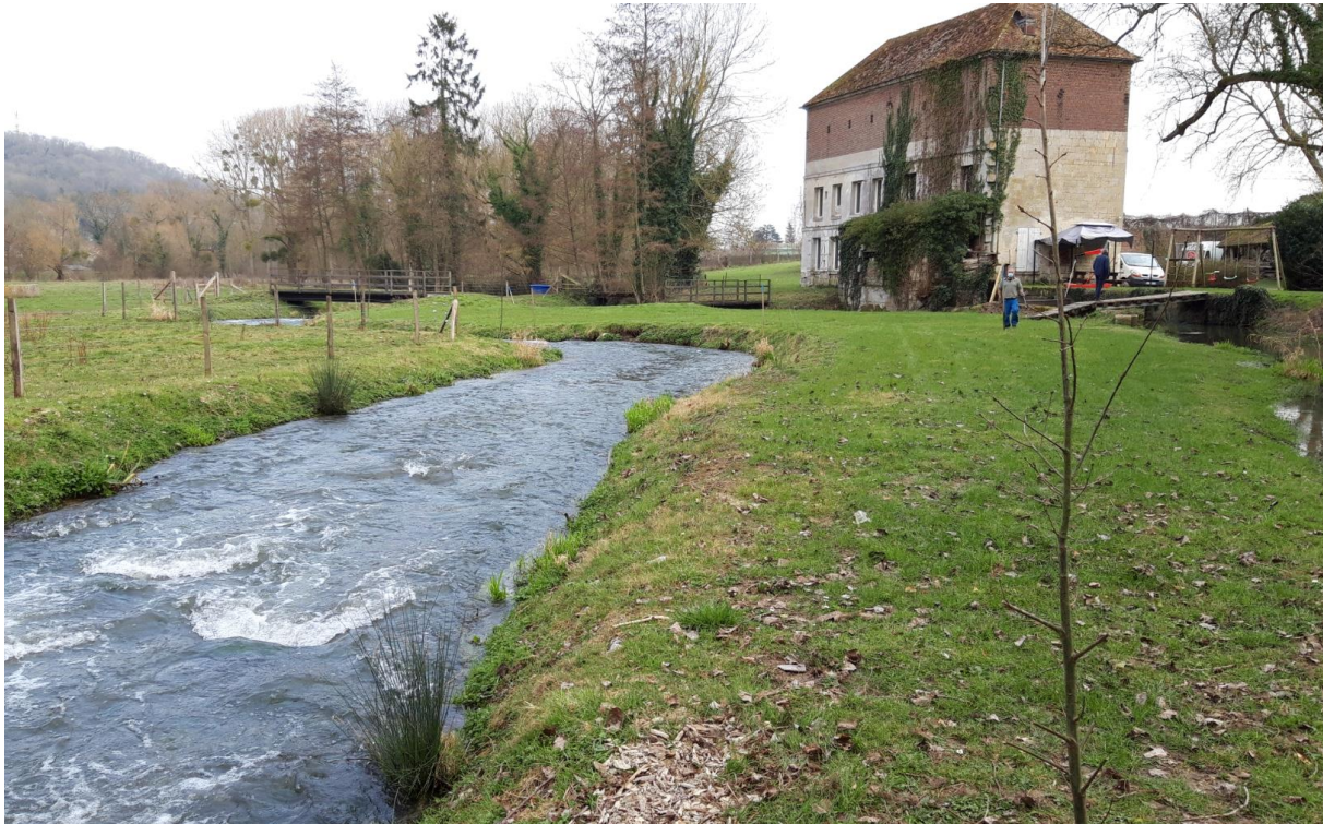
Exemple de bras de contournement réalisé après remblaiement préalable de la rive gauche du bief dans des conditions identiques au site du moulin de la Commanderie (projet de RCE du moulin de Froisselle sur l'Aronde à Clairoux – SOGETI 2019)
