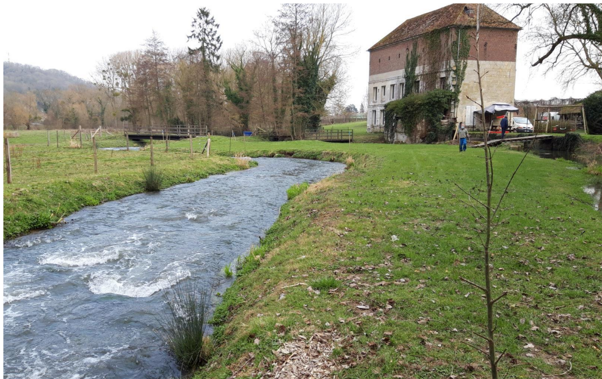
Figure 13 : Exemple de bras de contournement réalisé après remblaiement préalable de la rive gauche dans des conditions identiques au site du moulin de la Commanderie (projet de RCE du moulin de Froisselle sur l'Aronde à Clairoux – SOGETI 2019)
