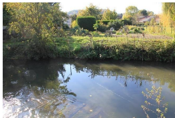
Berge en rive droite du bief maintenue par des pieux bois
