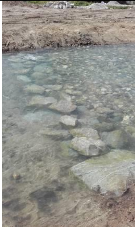
Photographie de la réalisation d'un ancrage de radier, avant recouvrement en blocs de petites tailles (SOGETI 2018 – Pisciculture Leblanc – Héricourt en Caux 76)
