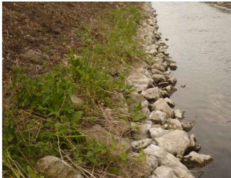
Photographie de berges réaménagées (bi-couche d'enrochements- Louviers (27) (SOGETI 2010)
