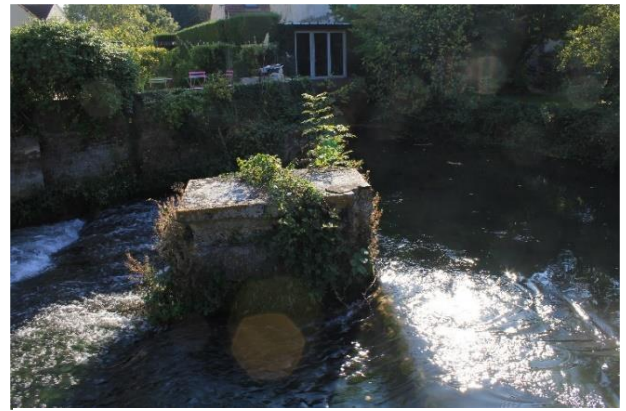
Figure 4 : Piles et IPN de l'ouvrage de décharge (rive gauche)
