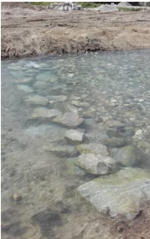
Figure 9 : Photographie de la réalisation d'un ancrage de radier, avant recouvrement en blocs de petites tailles (SOGETI 2018 – Pisciculture Leblanc – Héricourt en Caux 76)
