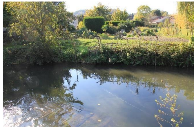
Figure 6 : Berge en rive droite du bief maintenue par des pieux bois
