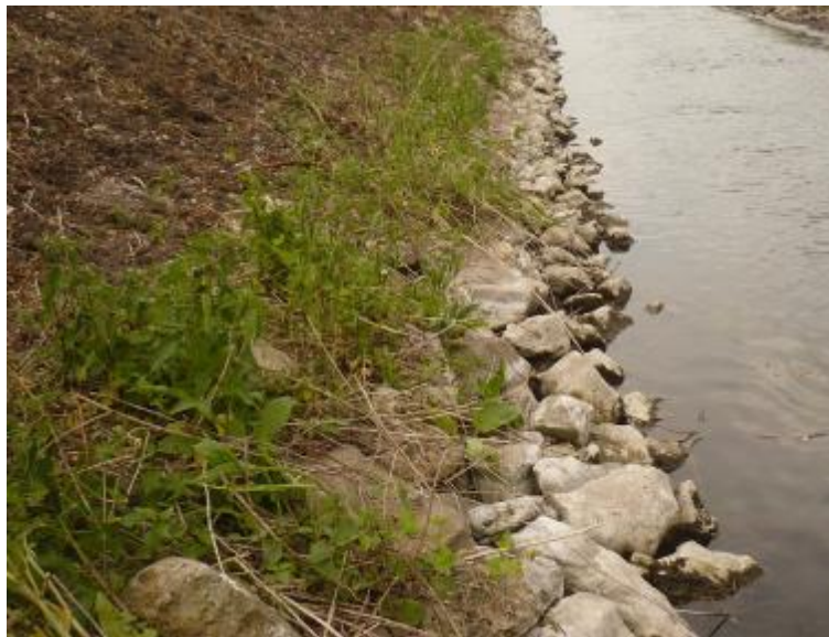
Figure 11 : Photographie de berges réaménagées (bi-couche d'enrochements- Louviers (27) (SOGETI 2010)
