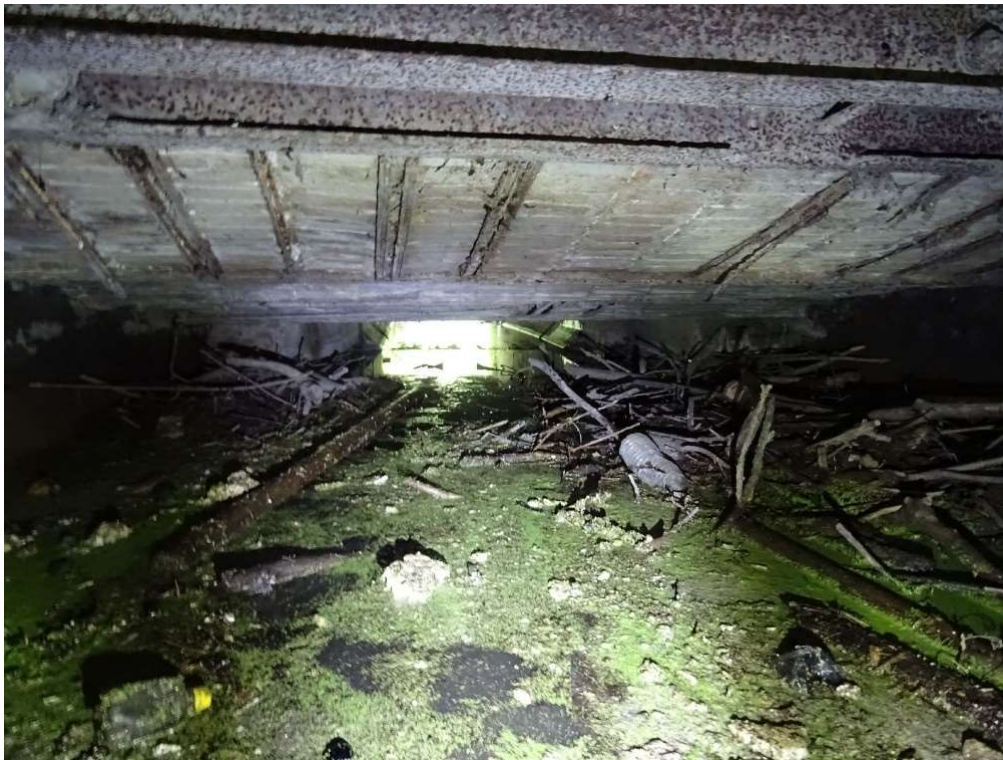
Ph.5 Vue de la structure n°2
