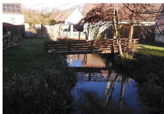
Succession de passerelles privées enjambant le canal usinier
