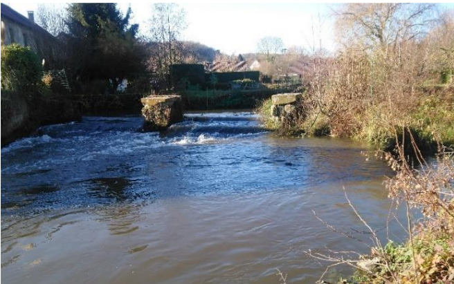
Figure 3 : Ouvrage de décharge (vue depuis l'aval)
