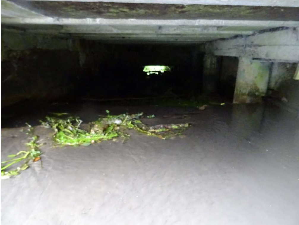
Ph.3 Vue générale de l'intérieur de l'ouvrage
