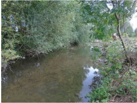
Figure 8 : Berges hautes merlon - Source : Syndicat des rivières du territoire de la Chalaronne
