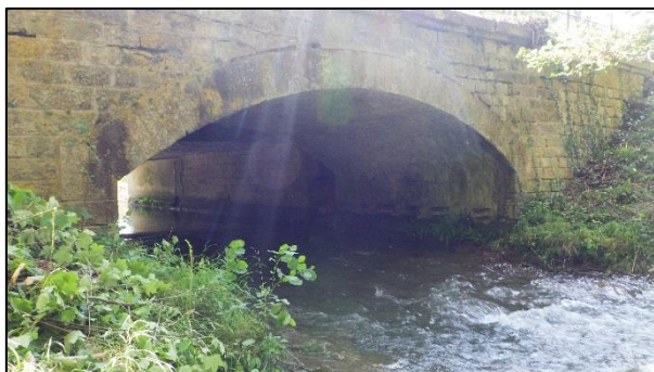
Figure 4 : Vue du pont SNCF depuis l'aval
