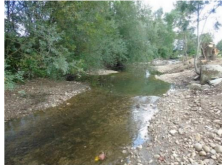
Figure 9 : Reprise des berges en pente douce et création de banquettes - Source : Syndicat des rivières du territoire de la Chalaronne
