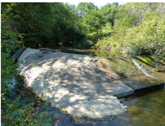
Figure 6 : Seuil et retenue de Gabanelle sur le Bervezou avant effacement (source SMBRC)
