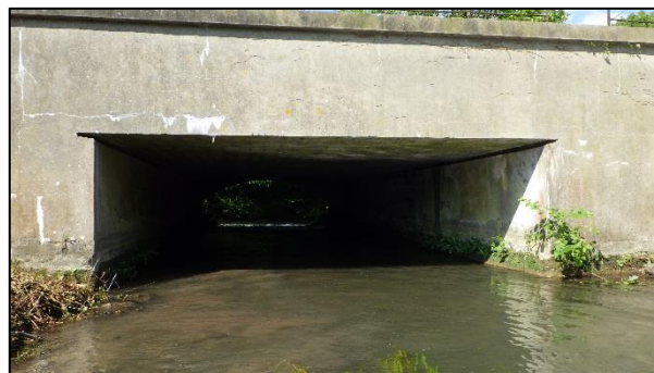
Figure 5 : Vue du pont SNCF depuis l'amont
