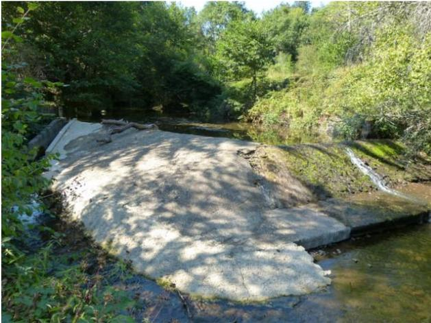
Figure 48 : Seuil et retenue de Gabanelle sur le Bervezou avant effacement (source SMBRC)
