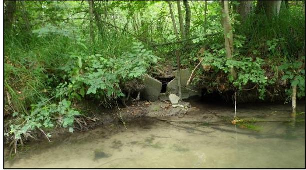
Figure 26 : Photo 6 : Renards hydrauliques dans la digue de l'étang
