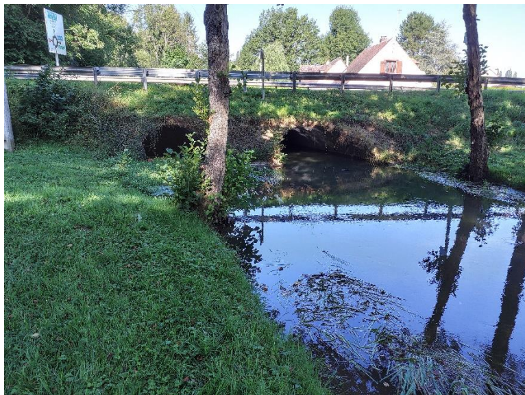
Figure 23. Le pont départemental (D151) est situé 60 m à l'amont des ouvrages.
