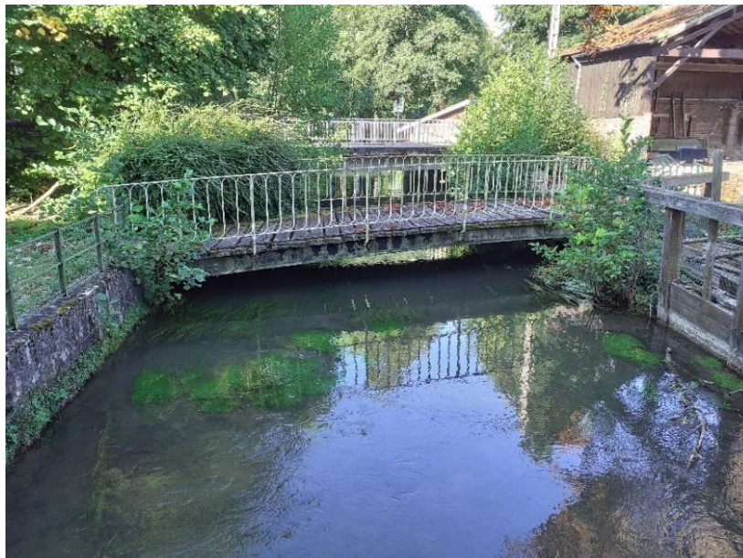
Figure 22. Passerelle piétonne privée vue aval en septembre 2021
