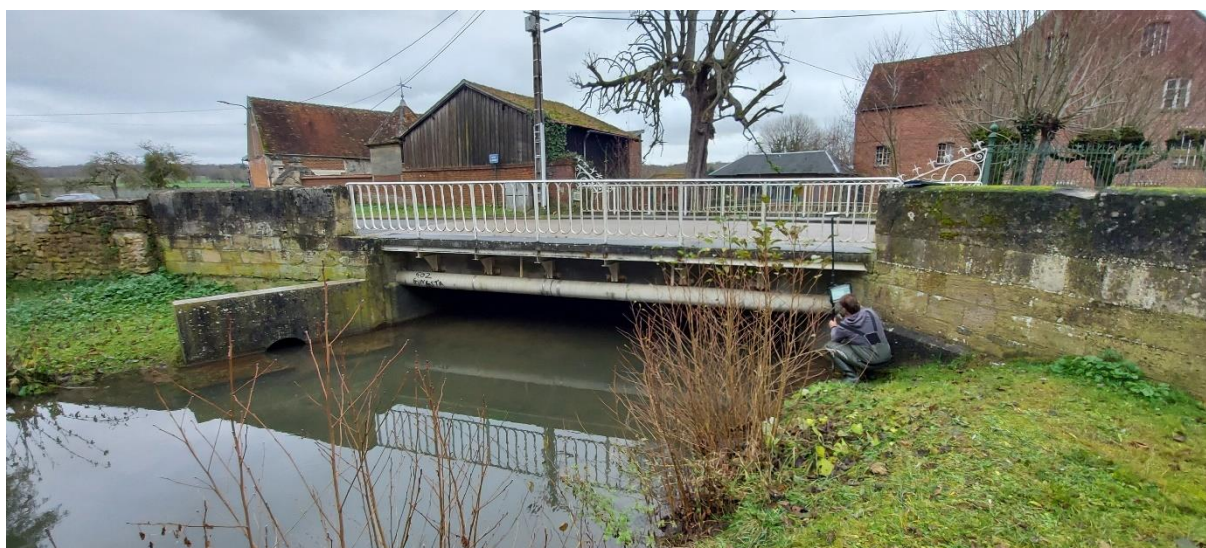
Figure 24. Passerelle communale située impasse de Ramecourt.
