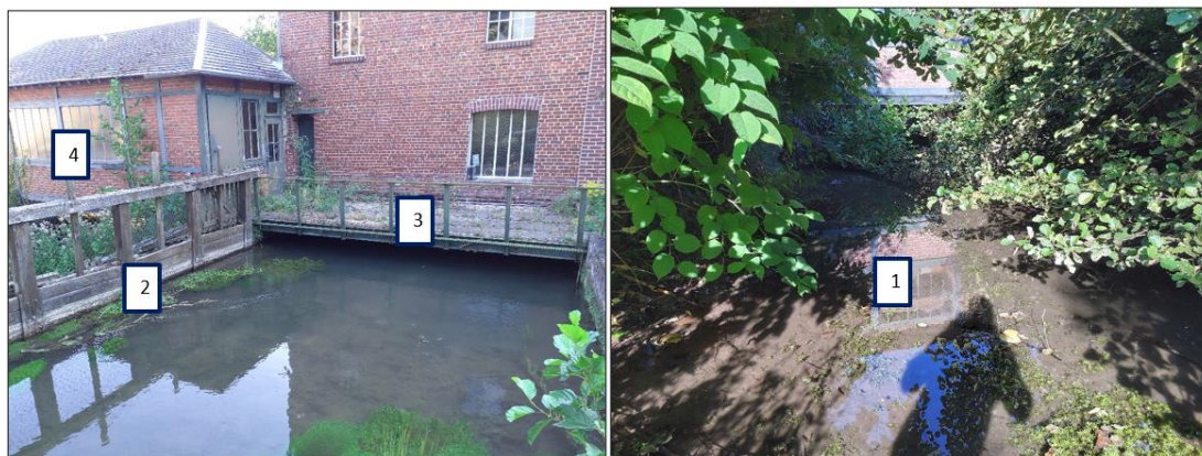
Figure 19. Le moulin de Ramecourt vue amont (à gauche), vue aval (à droite) en septembre 2021
