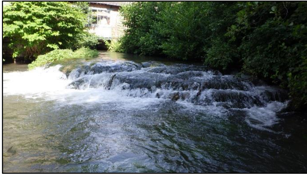
Figure 6 : Vue du seuil depuis l'aval
