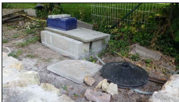
Figure 33 : Pompe pour l'alimentation d'un jardin
