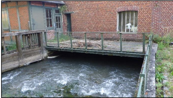
Figure 11 : Vue du canal usinier depuis l'amont
