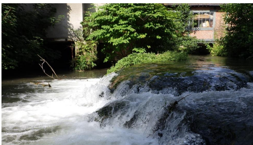
Figure 24 : Ecoulements dans le canal usinier (à gauche) et le canal de décharge (à droite)
