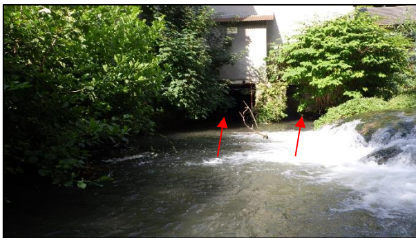
Figure 13 : Vue du canal usinier depuis l'aval
