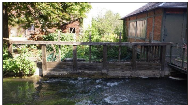
Figure 10 : Vue du vannage de décharge depuis l'amont
