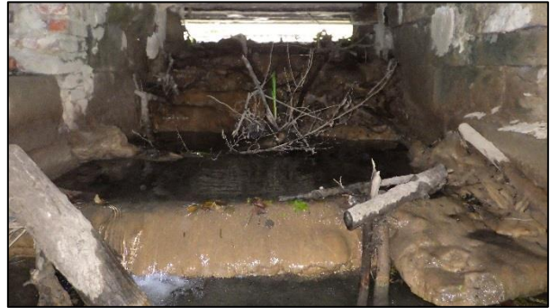
Figure 12 : Vue du pertuis usinier sous le moulin depuis l'aval
