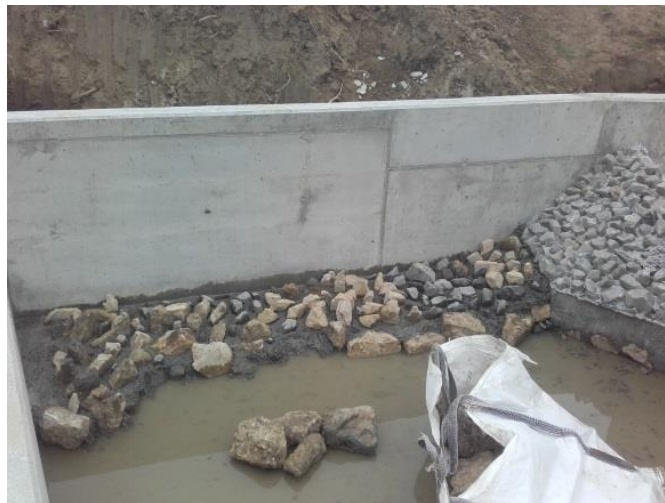
Figure 36 : Exemple d'une rampe et d'un chemin rugueux mis en place au niveau d'un pré-barrage (Source : SMBD)
