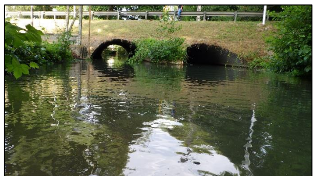
Figure 32 : Vue du pont départemental depuis l'amont
