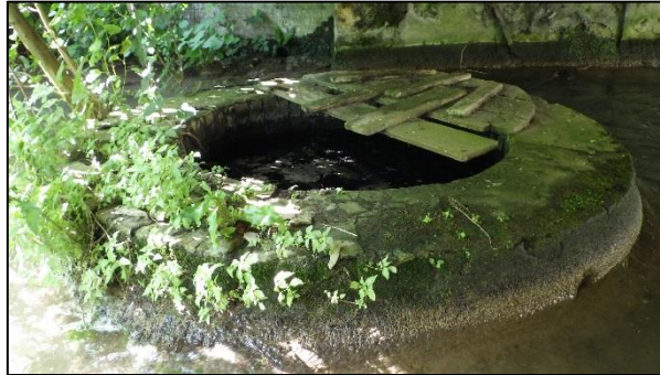
Figure 8 : Socle de l'ancienne machine à vapeur situé en amont du seuil secondaire
