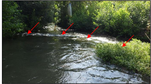
Figure 7 : Vue du seuil depuis l'amont
