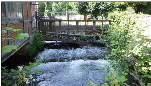
Figure 9 : Vue du vannage de décharge depuis l'aval
