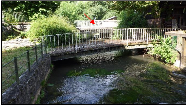
Figure 29 : Vue du pont communal depuis l'aval
