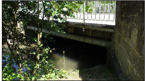
Figure 30 : Vue du pont communal depuis la rive droite amont
