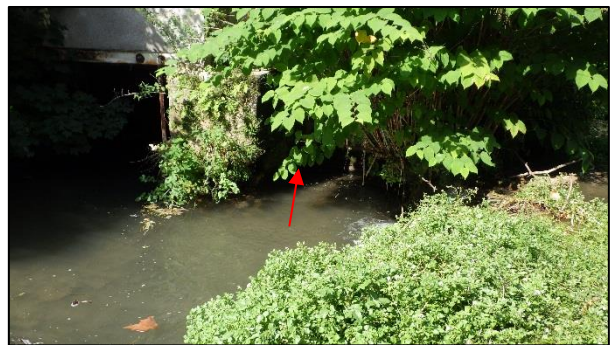
Figure 14 : Vue du pertuis aujourd'hui obturé depuis l'aval
