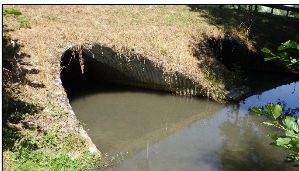
Figure 31 : Vue du pont départemental depuis l'aval
