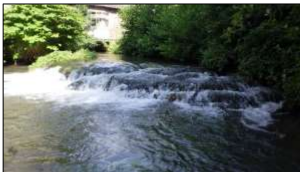
Vue du seuil depuis l'aval
