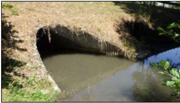
Vue du pont départemental depuis l'aval
