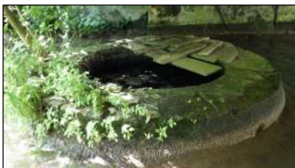
Socle de l'ancienne machine à vapeur situé en amont du seuil secondaire
