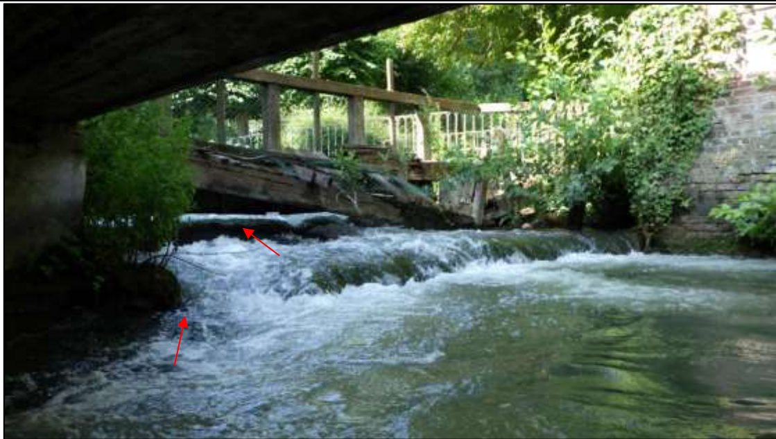
Localisation de la voie de franchissement préférentielles au vannage de décharge
