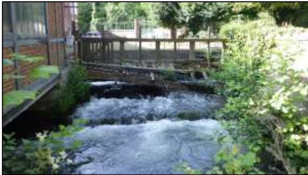
Vue du vannage de décharge depuis l'aval
