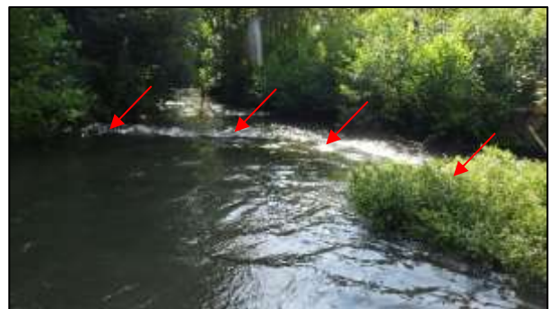
Vue du seuil depuis l'amont
