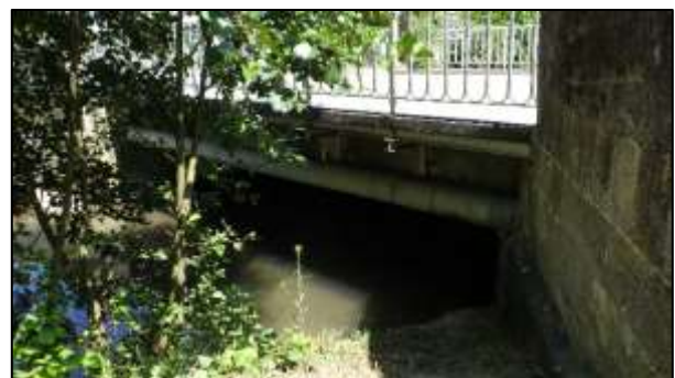
Vue du pont communal depuis la rive droite amont
