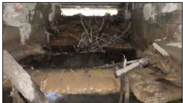
Vue du pertuis usinier sous le moulin depuis l'aval
