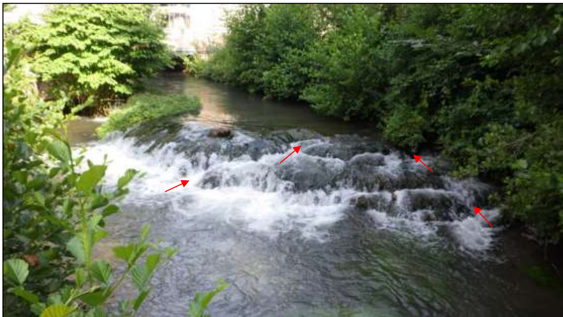
Localisation des voies de franchissement préférentielles sur le seuil secondaire
