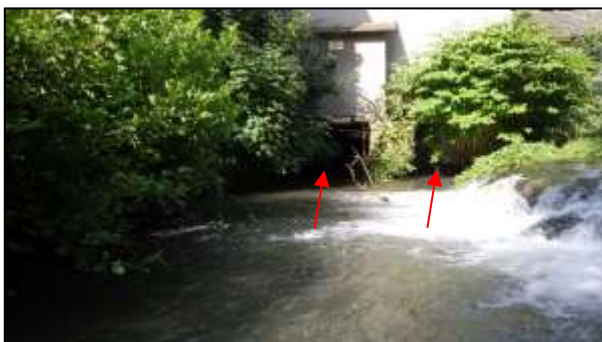
Vue des canaux de fuites depuis l'aval
