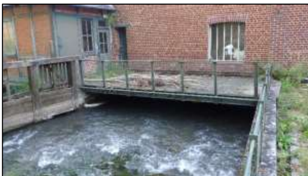
Vue du canal usinier depuis l'amont
