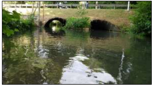
Vue du pont départemental depuis l'amont
