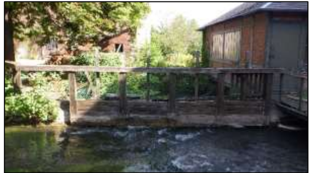
Vue du vannage de décharge depuis l'amont
