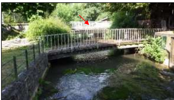
Vue du pont communal depuis l'aval au niveau du vannage de décharge
