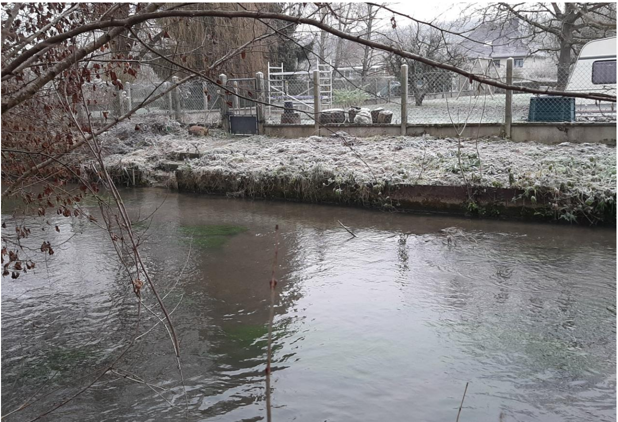
Vue de la berge rive gauche laissant apparaître des plaques en béton utilisées comme protections de berges
