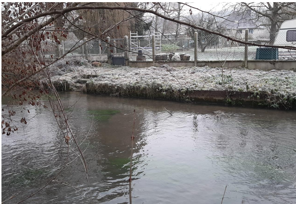
Vue de la berge rive gauche laissant apparaître des tôles ondulées utilisées comme protections de berges
