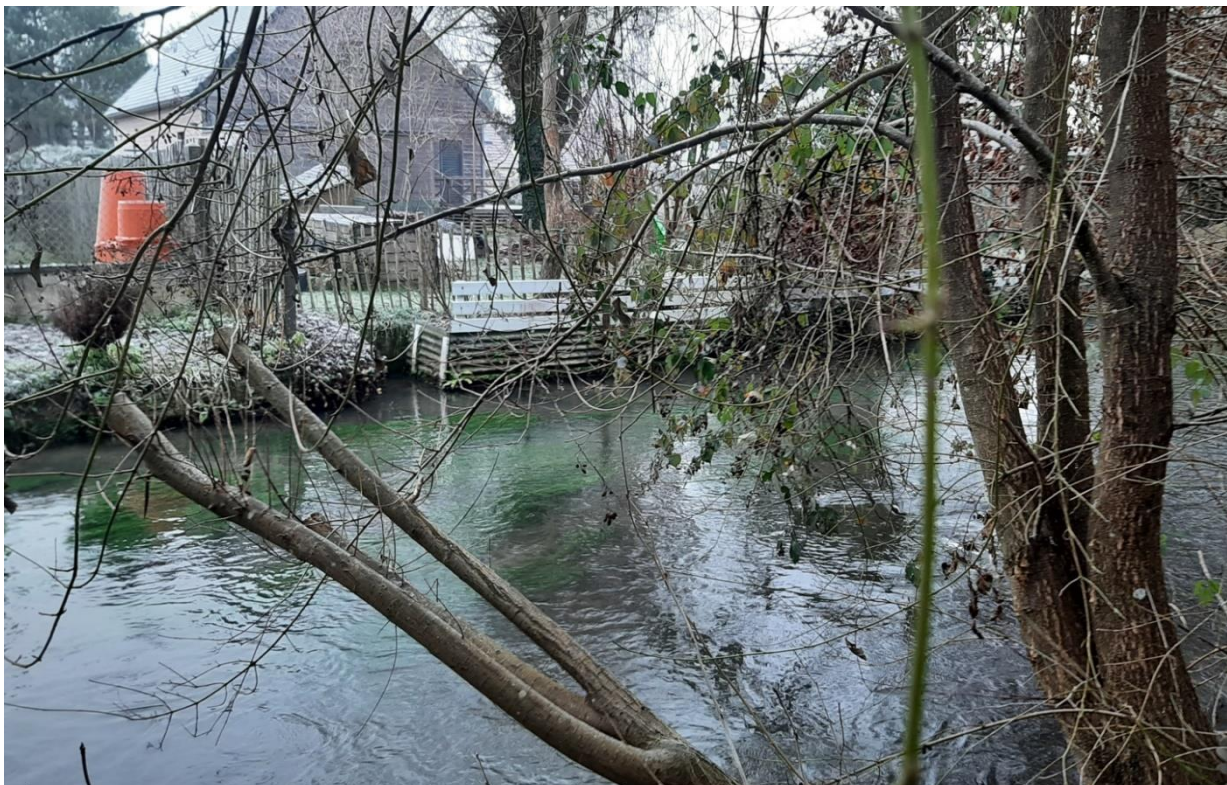
Vue de la berge rive gauche laissant apparaître des tôles ondulées utilisées comme protection de berges
