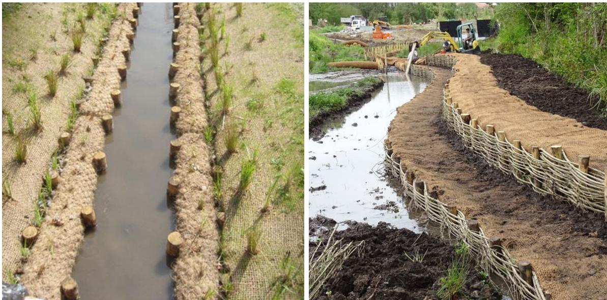
Figure 36- Exemple de réalisation de génie végétal avec boudin d'hélophytes à gauche et fascines superposées à droite.
