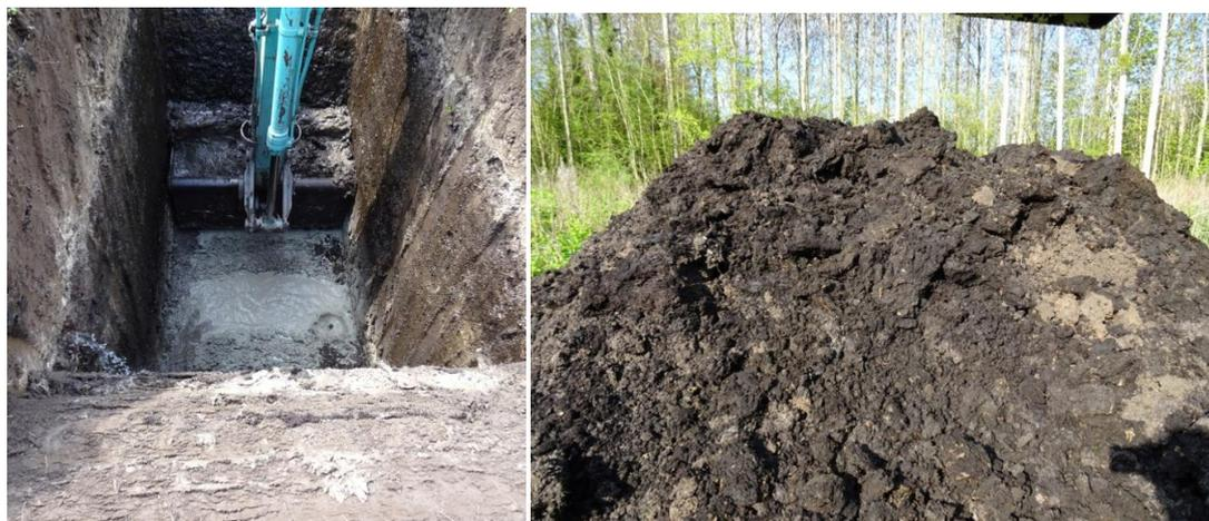
Figure 31- Tenue des fouilles à court terme et comportement des terres en dépôt.
