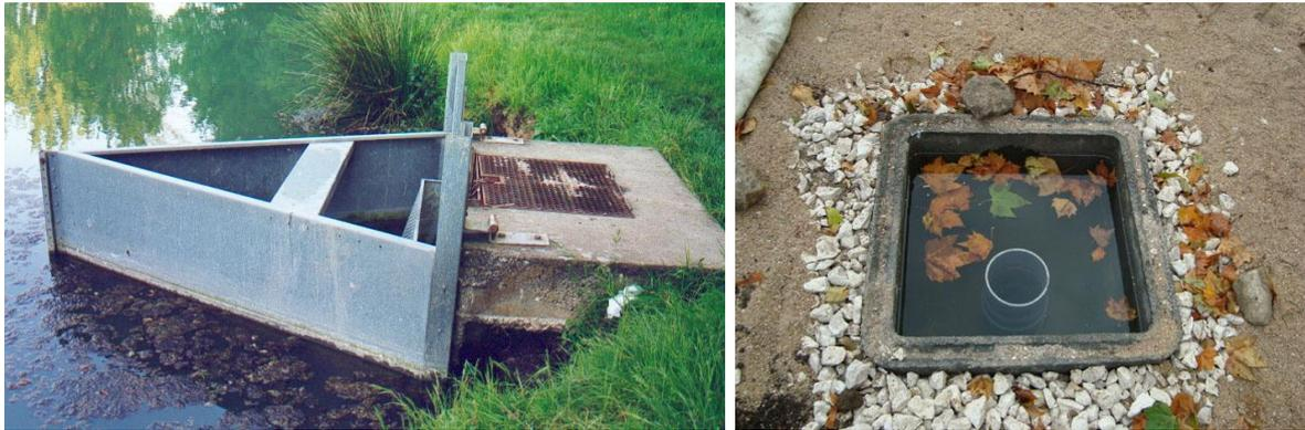
Figure 39- Typologie d'ouvrage de rejet avec moine et regard réglable à débordement.
