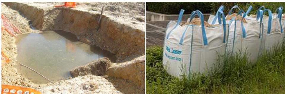
Figure 28– Principe de filtration/décantation aval et noyau de confinement en big bag.
