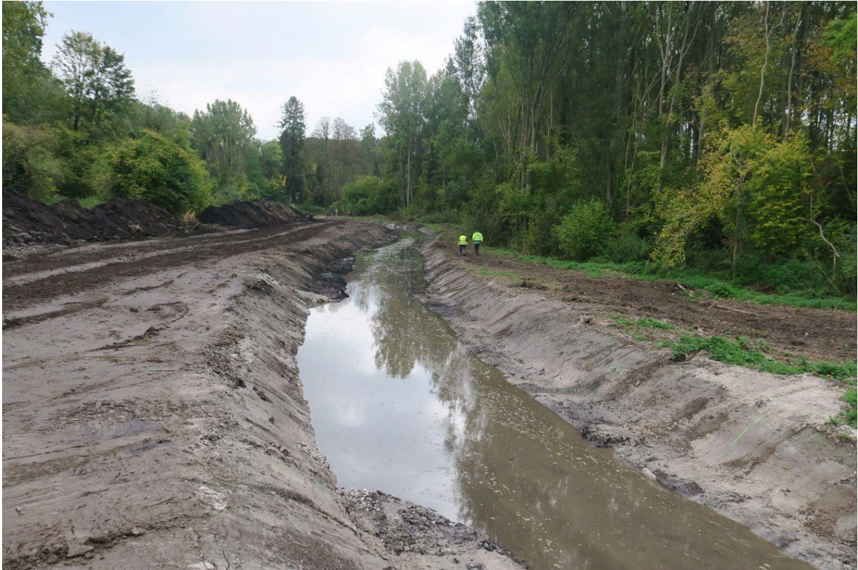
Les berges à la fin du chantier il y a un an. LP/J.H.
