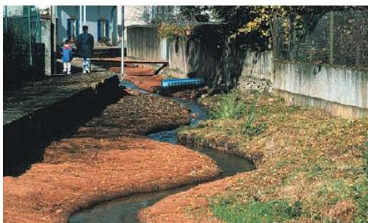
Le ruisseau de Montvaux pendant les travaux de restauration. Pose du géotextile en fibre de coco (octobre 1999).
