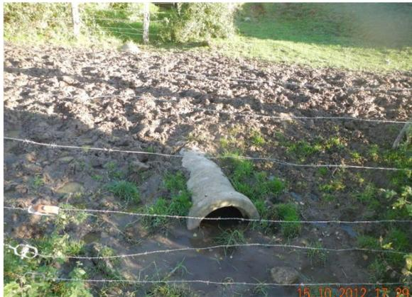
Passage à gué pour le bétail : un changement de la buse et un rapprochement des clôtures pour éviter le piétinement dans le lit est nécessaire
