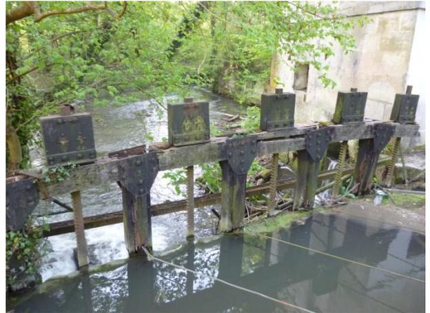
Vannage OH\_121 sur le canal de fuite délabré (retenu par des cables)
