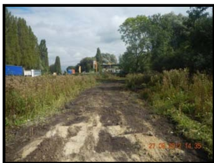
Zone humide subissant des travaux sur la commune de Villers-st-Paul
