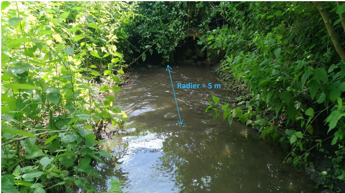
Photo 5 : Zone de radier en amont de l'ouvrage sous l'impasse Louis Pergaud
