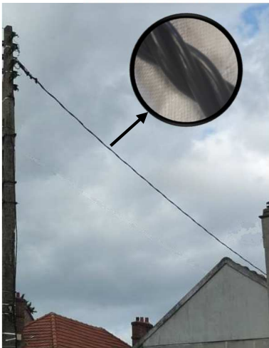
Réseau fils isolés aérien BT
