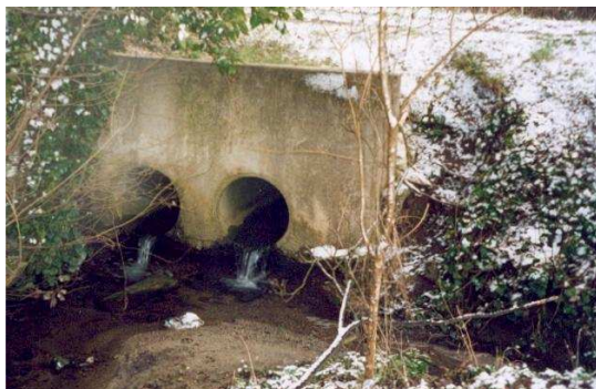
Figure n° -20- OH de franchissement du CR poursuivant la rue neuve.
