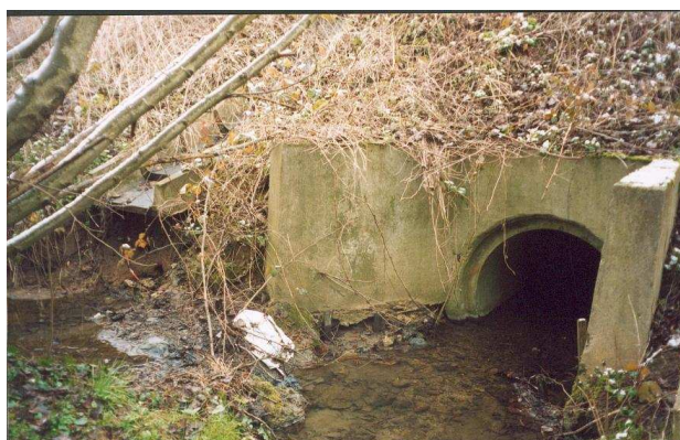
Figure n° 21- Etat de l'ouvrage hydraulique sous la RN 16
