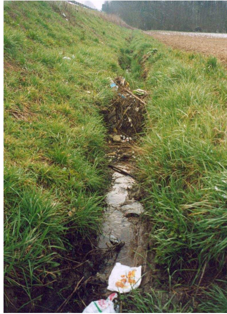
Figure n°11 - Etat du fossé latéral le long de la RN 16.
