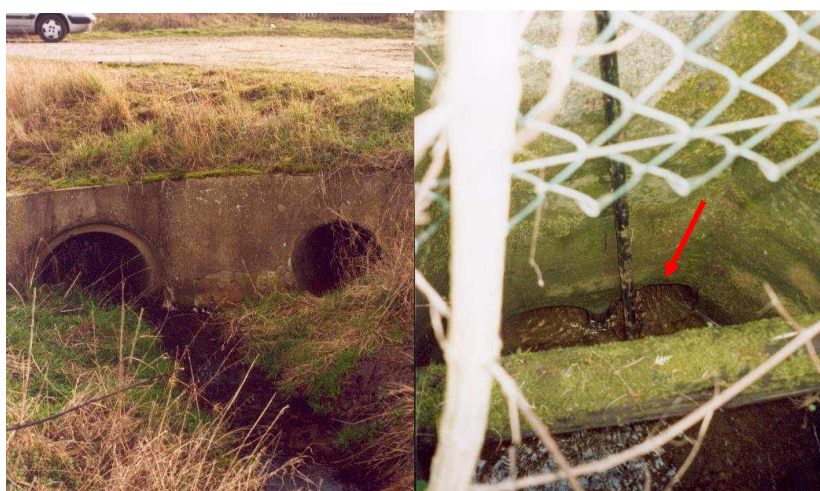
Figure n° 16- Ouvrages sous la Voie SNCF . –
